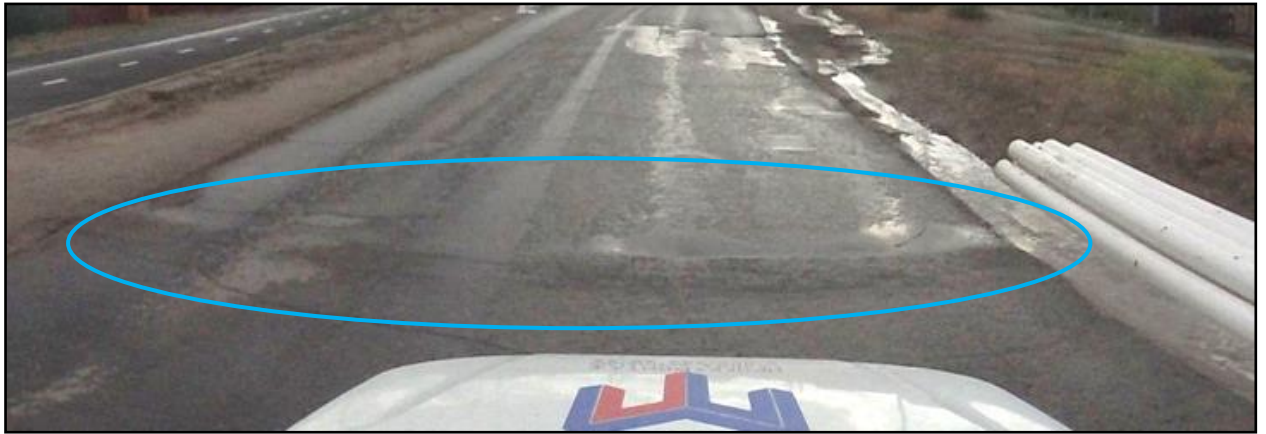
Рисунок 1.6.15 – Пример исполнения ИН монолитной конструкции, расположенной на ул. 40 лет Победы, р.п. Новоспасское
