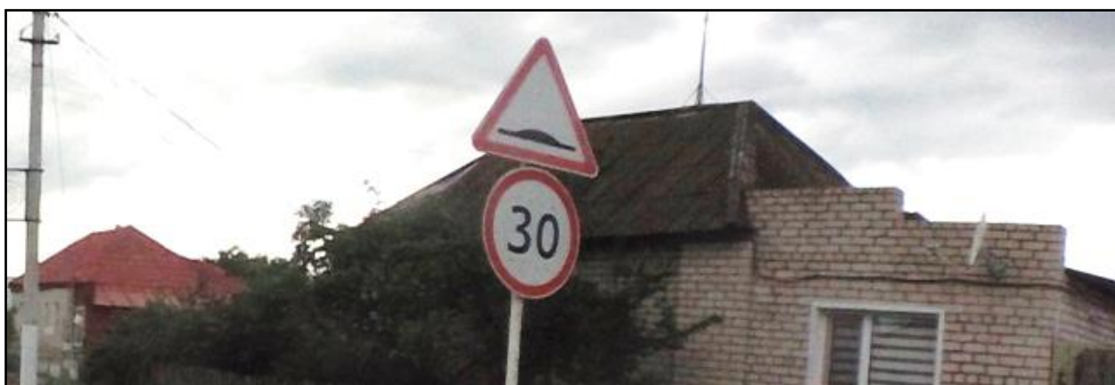
Рисунок 1.6.6 – Вид эксплуатационного состояния знака 5.20 «Искусственная неровность» и знака 3.24 «Ограничение максимальной скорости», расположенного по ул. Свердлова, р.п. Новоспасское
