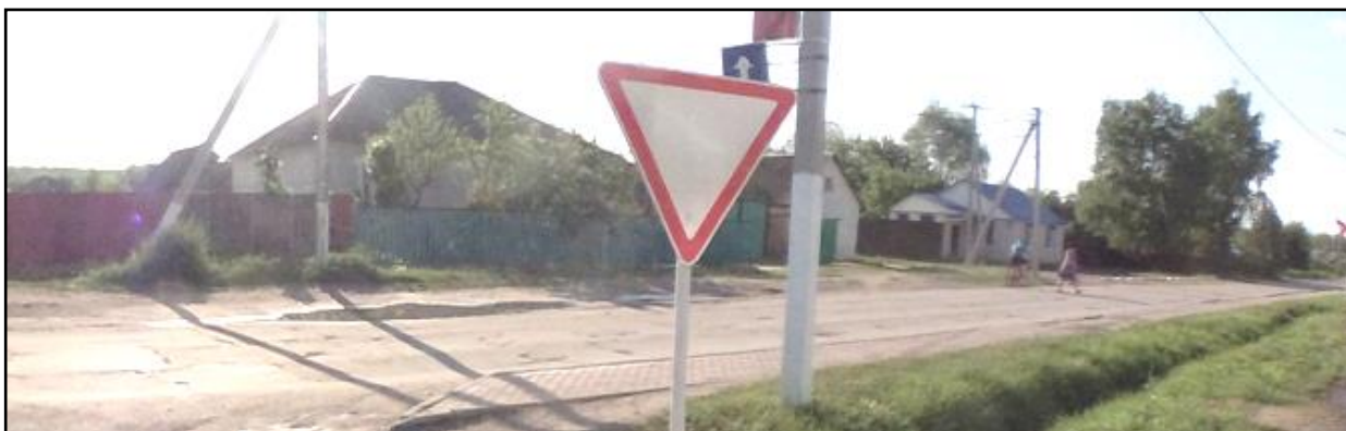
Рисунок 1.6.5 – Вид эксплуатационного состояния знака 2.4 «Уступите дорогу», расположенного по ул. Механизации, р.п. Новоспасское
