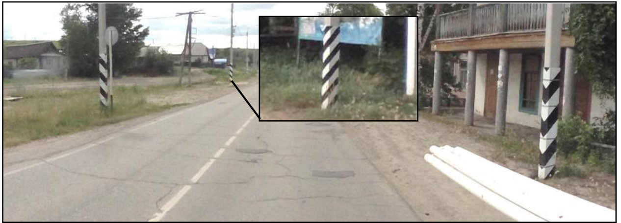
Рисунок 1.6.10 – Пример эксплуатационного состояния вертикальной разметки 2.1.3 (обозначающей опоры освещения расположенные в пределах обочины на расстоянии менее 1 м от края проезжей части), нанесённой на ул. Советская, р.п. Новоспасское
