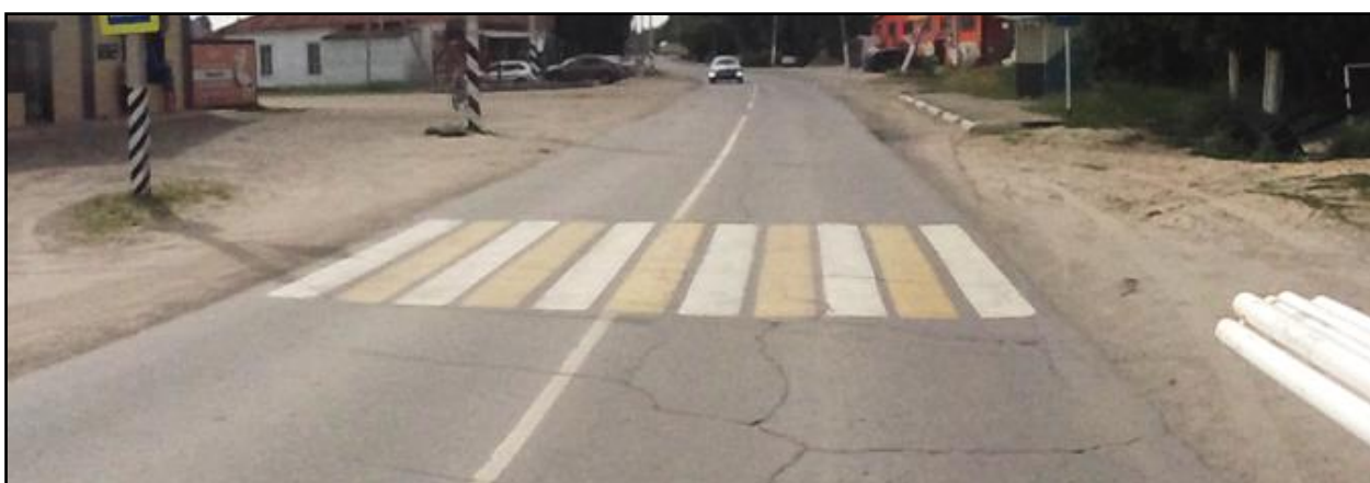
Рисунок 1.6.9 – Пример эксплуатационного состояния горизонтальной разметки 1.1 (разделяющей транспортные потоки) и 1.14.1 с жёлтым заполнением (обозначающей пешеходный переход), нанесённых на ул. Советская, р.п. Новоспасское
