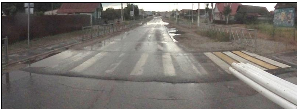
Рисунок 1.6.14 – Пример исполнения и эксплуатационного состояния ИН монолитной конструкции, расположенной на ул. 40 лет Победы, р.п. Новоспасское
