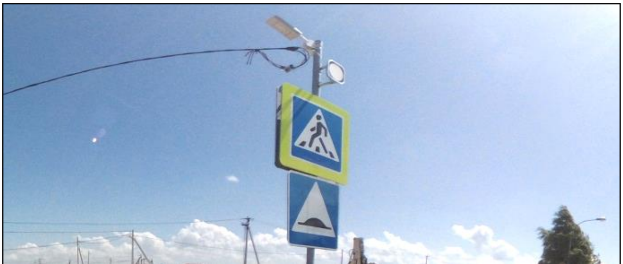
Рисунок 1.6.3 – Пример эксплуатационного состояния светофора типа Т.7 установленного по ул. Аэродромная, р.п. Новоспасское
