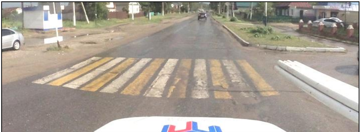
Рисунок 1.6.11 – Пример неудовлетворительного эксплуатационного состояния горизонтальной разметки 1.14.1 с жёлтым заполнением (обозначающей пешеходный переход), нанесённой на ул. Мичурина, р.п. Новоспасское
