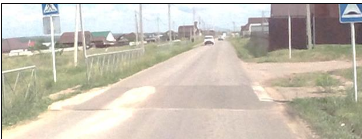
Рисунок 1.6.13 – Пример исполнения и эксплуатационного состояния ИН монолитной конструкции, расположенной на ул. Аэродромная, р.п. Новоспасское
