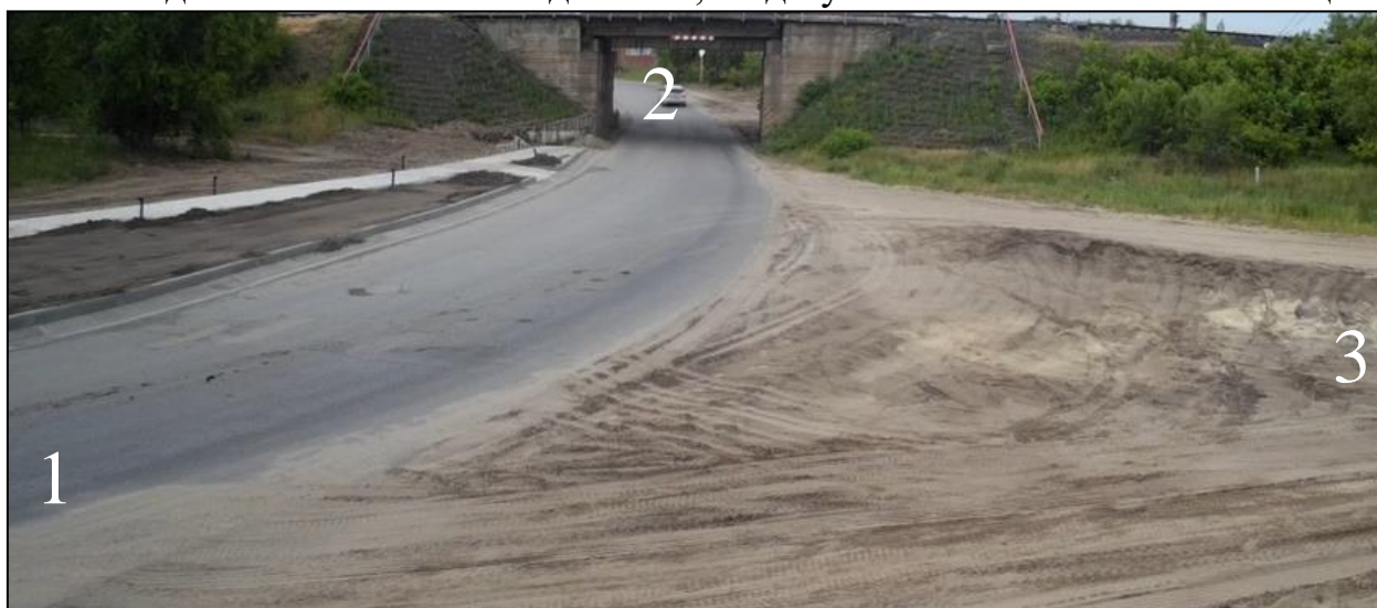
Рисунок Г.16.2 – Фото перекрестка: ул. Строителей – ул. Ленина
