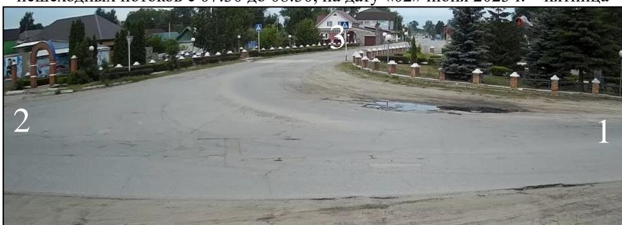
Рисунок Г.17.2 – Фото перекрестка: ул. Строителей – ул. Мичурина – ул. Мира
